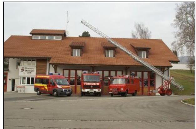
Gerätehaus und Fahrzeuge
